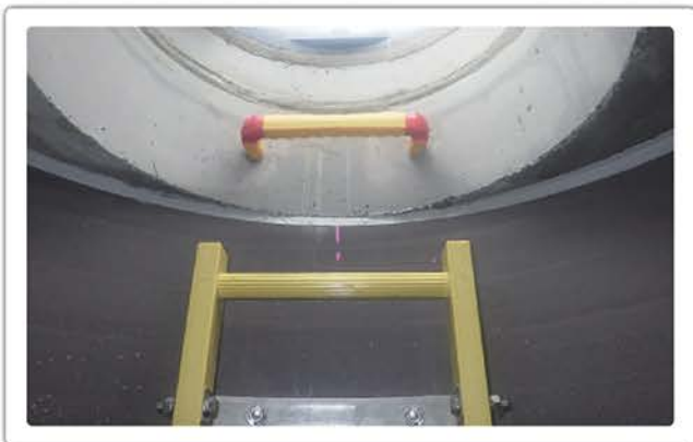
更生材・SSブロック(スラブ)離隔確認
