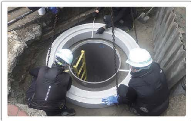
SSブロック(基礎版)据付
