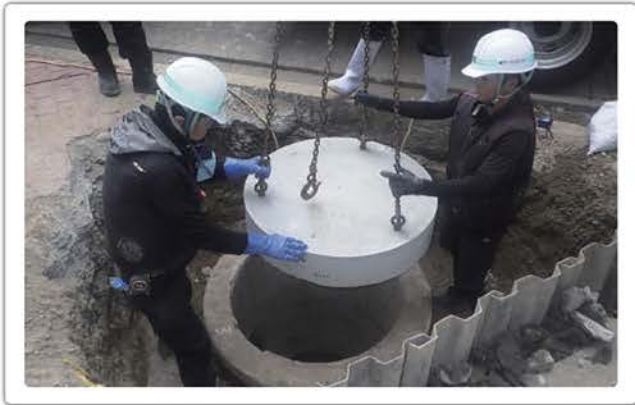
SSブロック(底版)据付
