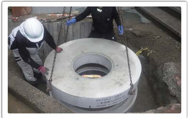
SSブロック(スラブ)据付
