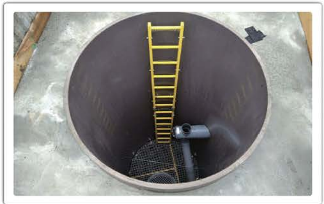
更生材据付完了
